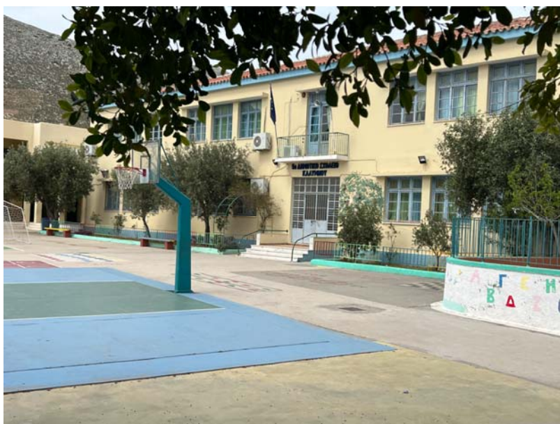
Εικόνα 3.2 Πρόσβαση στην κεντρική πύλη του σχολικού συγκροτήματος (πάνω) Πρόσβαση από τον αύλειο χώρο στην είσοδο του κτιρίου του 5 ου Δημοτικού (κάτω)
